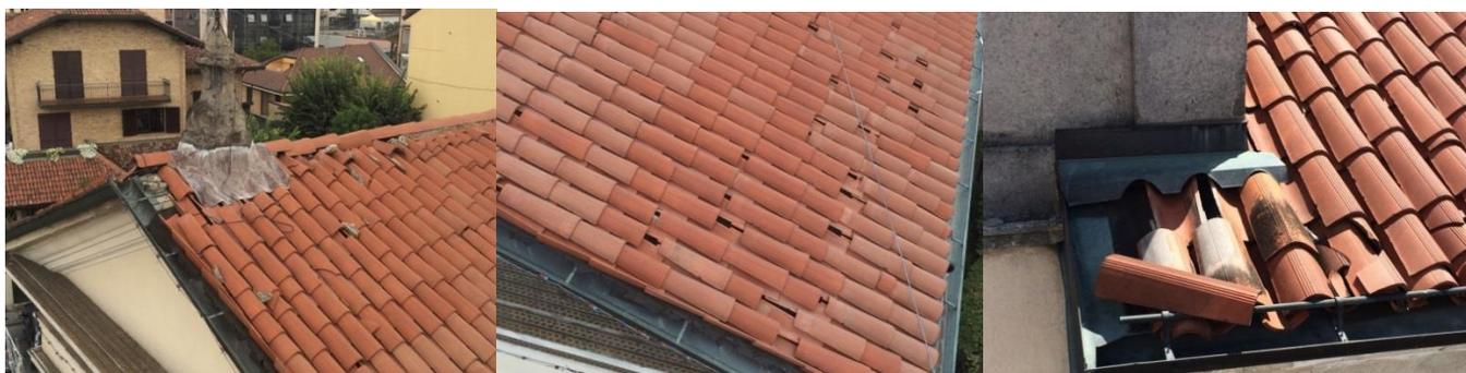
5) verifica dei canali e pluviali esistenti e consolidamento delle parti instabili della gronda e del campanile. Il tutto senza mutare l'aspetto formale e cromatico del tetto, considerati i vincoli esistenti per gli edifici posti in centro storico.
