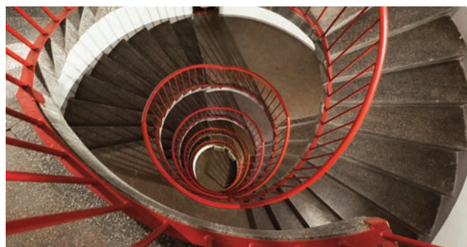
La caratteristica scala di sicurezza a chiocciola
